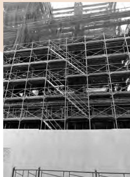
チェックリスト改善のきっかけとなった赤羽消防庁舎改築工事の様子(2019年3月撮影)
