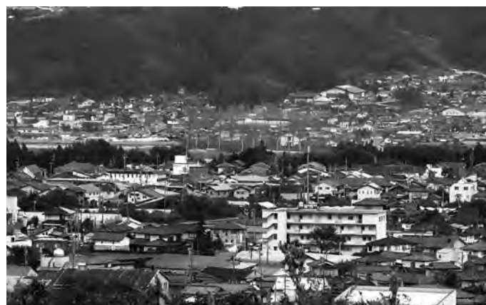
住民の承諾も補償交渉もないリニアルート(写真中央の住宅街)
