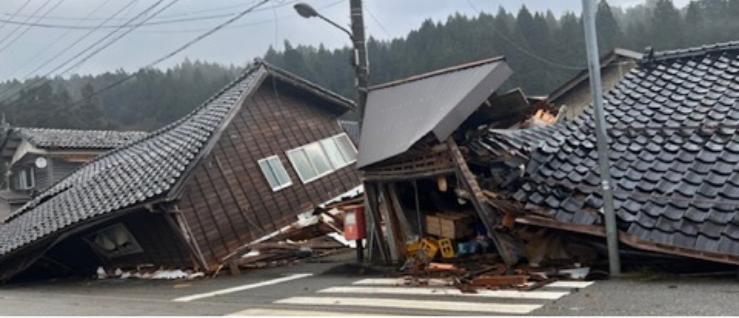
穴水町 道路沿いの民家（木造）倒壊 6日
