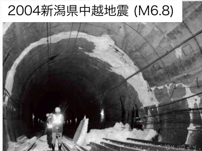
写真-3 地質不良区間での被害例（魚沼トンネル）
