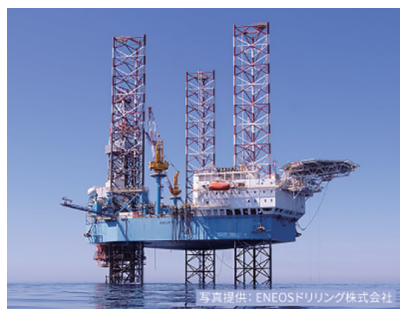
海上掘削リグ 海上の高さは約 120m 首都圏 CCS 株式会社ウェブページより
