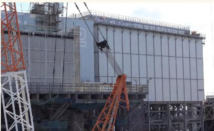
建屋（左）横に使用済み核燃料取り出し用の構台が建設された2号機＝いずれも2025年1月、筆者撮影
