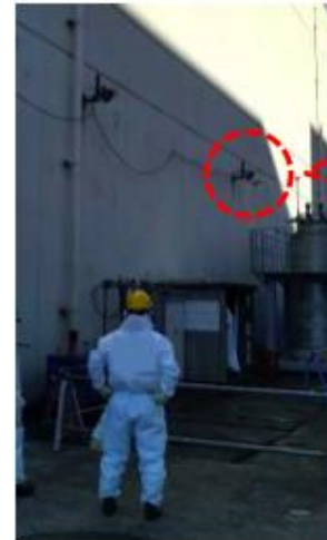
【現場状況(建屋外観)】
