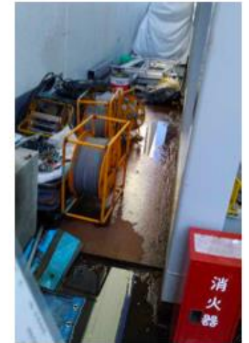
【敷き鉄板の状況】
