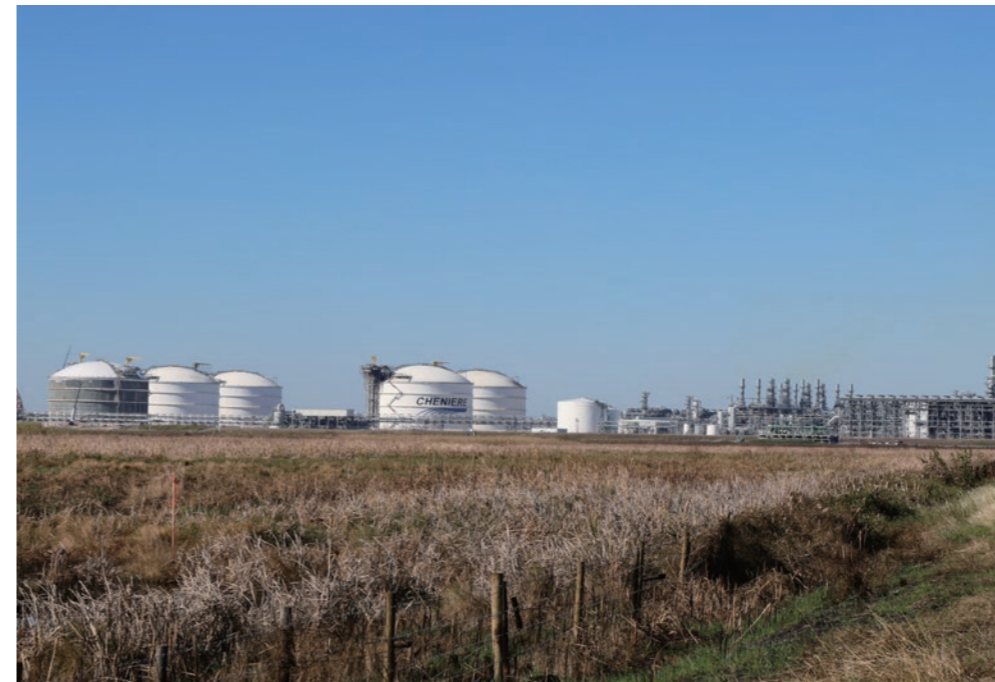
ルイジアナ州南東部の LNG ターミナルと LNG タンカー ©Fossil Free Japan
