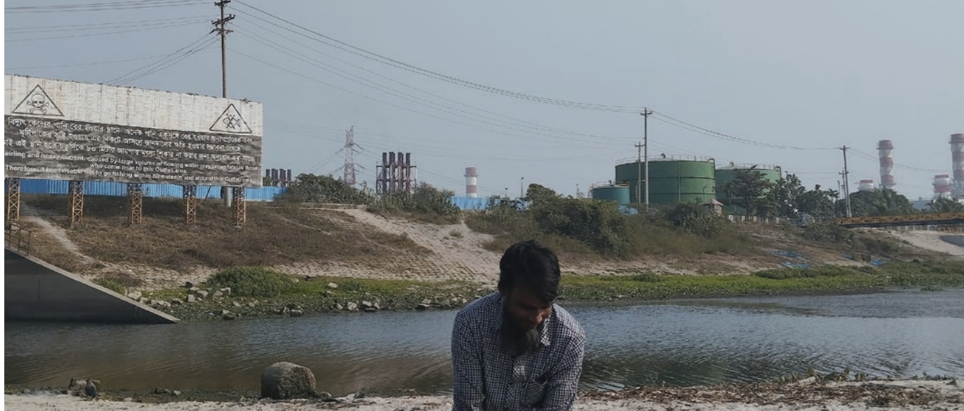
発電所の温水排出エリア。川に直接つながっている ©CLEAN, バングラデシュ
