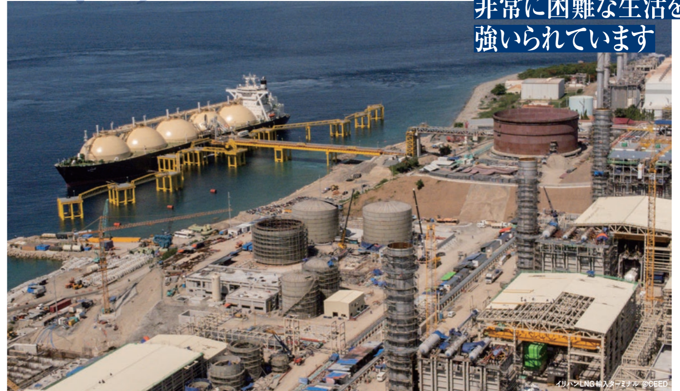
イリハンLNG輸入ターミナル ©CEED
