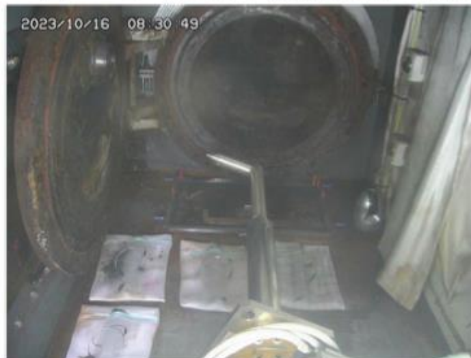
図4.X-6ペネハッチの開放後の状況② (X-6ペネを正面から見た状況 左がハッチ(蓋))
