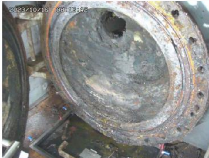
図2.X-6ペネハッチの開放作業中の状況
