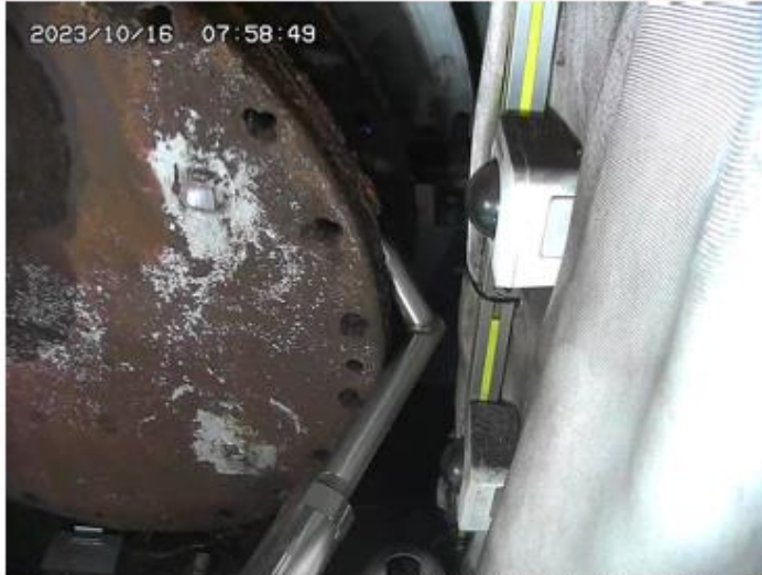
図1. X-6ペネハッチの開放作業前の状況
