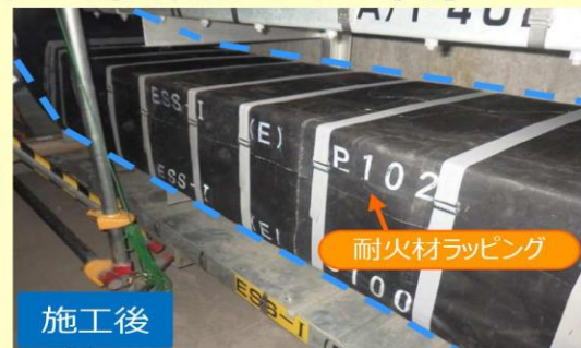
【順次実施している「ケーブルトレイへの耐火材ラッピング工事」】
