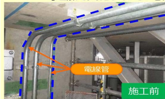
【追加で実施している「電線管への耐火材ラッピング工事」】
