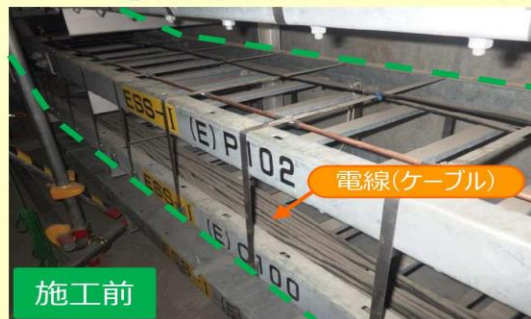
【順次実施している「ケーブルトレイへの耐火材ラッピング工事」】
