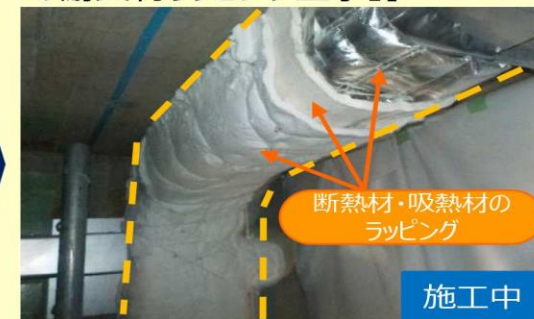
【追加で実施している「電線管への耐火材ラッピング工事」】
