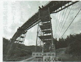
岐阜県瑞浪市のリニアトンネル工事現場から残土を運ぶベルトコンベアー。(撮影/井澤宏明)
