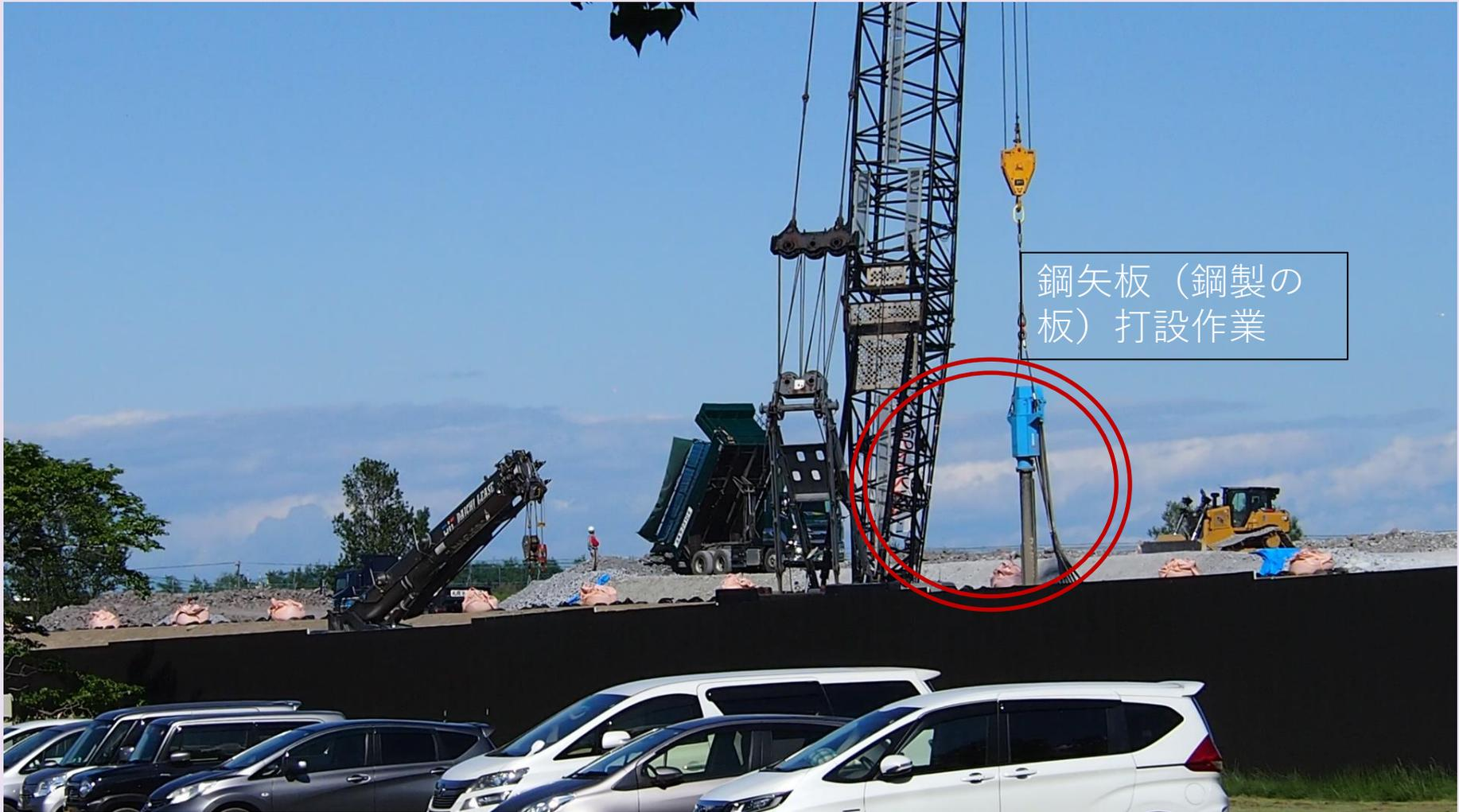
鋼矢板（鋼製の板）打設作業
