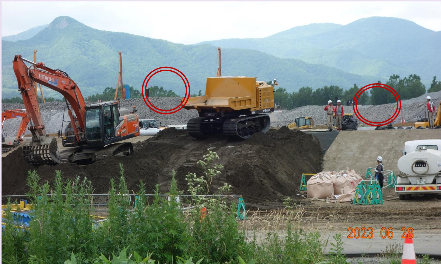
作業員の後ろは、土・砂等から「碎石」に替わった「有害掘削土」
