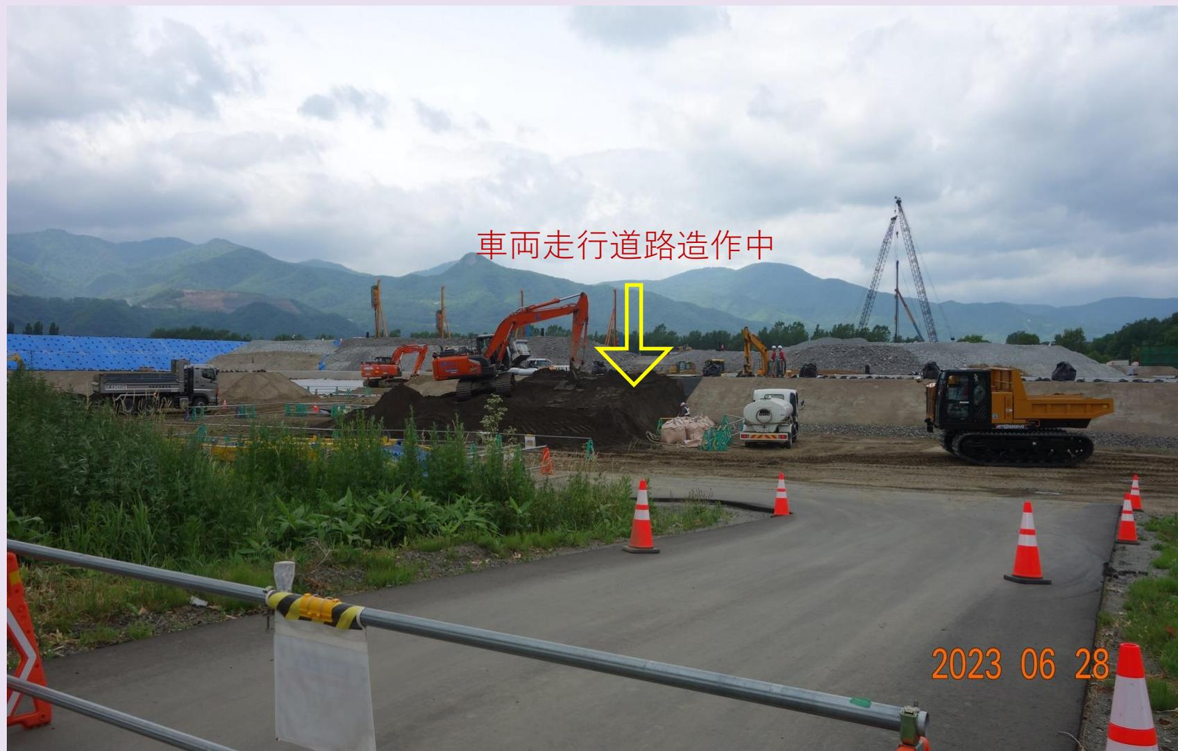
ダンプの進入道路造成中(左手重機で砂とコンクリートを混在作業中)
