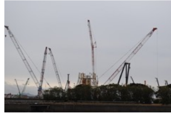
新設工事が進む横須賀石炭火力
