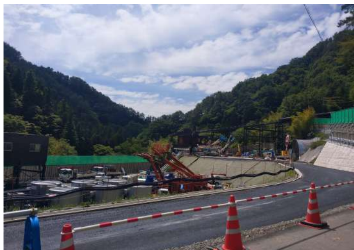
長野県豊丘村のトンネル非常口
