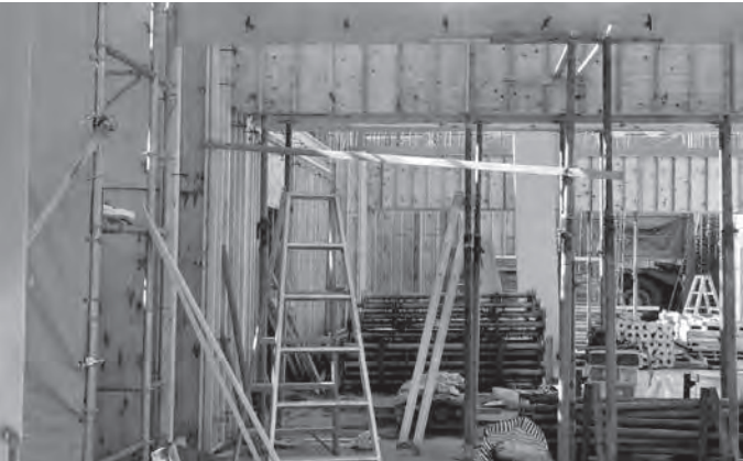
板橋区営住宅の工事の型枠用合板使用の様子
