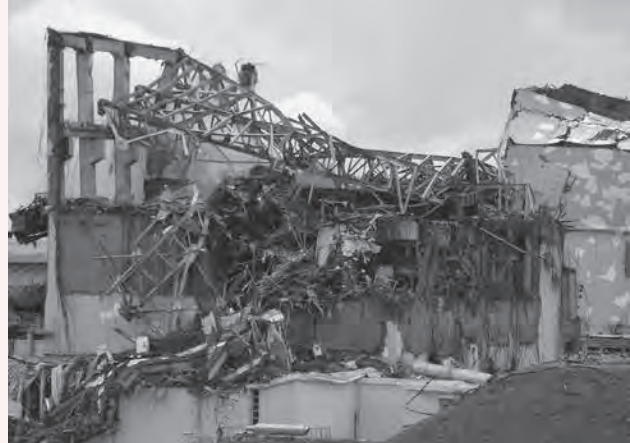
爆発後の原子炉建屋の外観（出典:東京電力ホールディングス）
