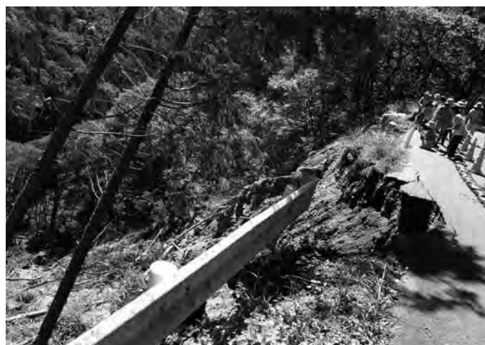
7月の豪雨による大鹿村の地滑り被害の様子
