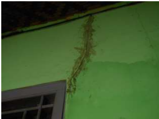
2014年9月の発電所内での爆発事故により損傷を受けたチレボン県ムンドゥ郡ワルドゥウル村 の家屋。発電所から半径1km以内。自費で修理。 (2015年2月)
