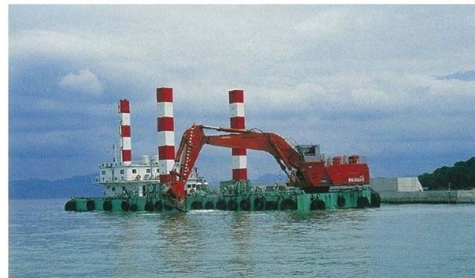
写 2.1-4 バックホウ浚渫の施工状況の例
