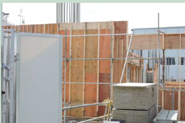
板橋区立小学校の新築工事で使用される熱帯型枠用合板
