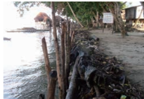
海岸侵食を防ぐため住民たちが杭を打っている(バブアニューギニア)
