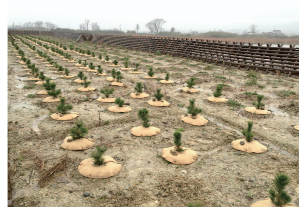
植樹後7ヶ月が経った海岸林のクロマツの苗木。厳しい海風や降雨で盛土が崩れないように麻製の防草シートを被せてある。
