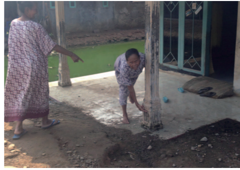
海面上昇対策に何度床を高くしても繰り返される浸水被害（インドネシア）
