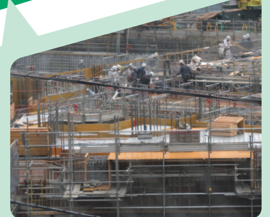
都内のタワーマンション建設現場の様子: オレンジ色の板がコンクリート型枠合板。
