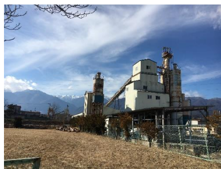
宮田村における処分場建設予定地
